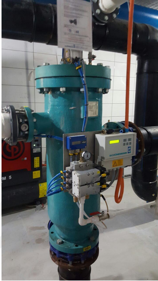
Şekil 4.12. Sistemde kullanılan Bernoulli filtre ve bağlantısı
