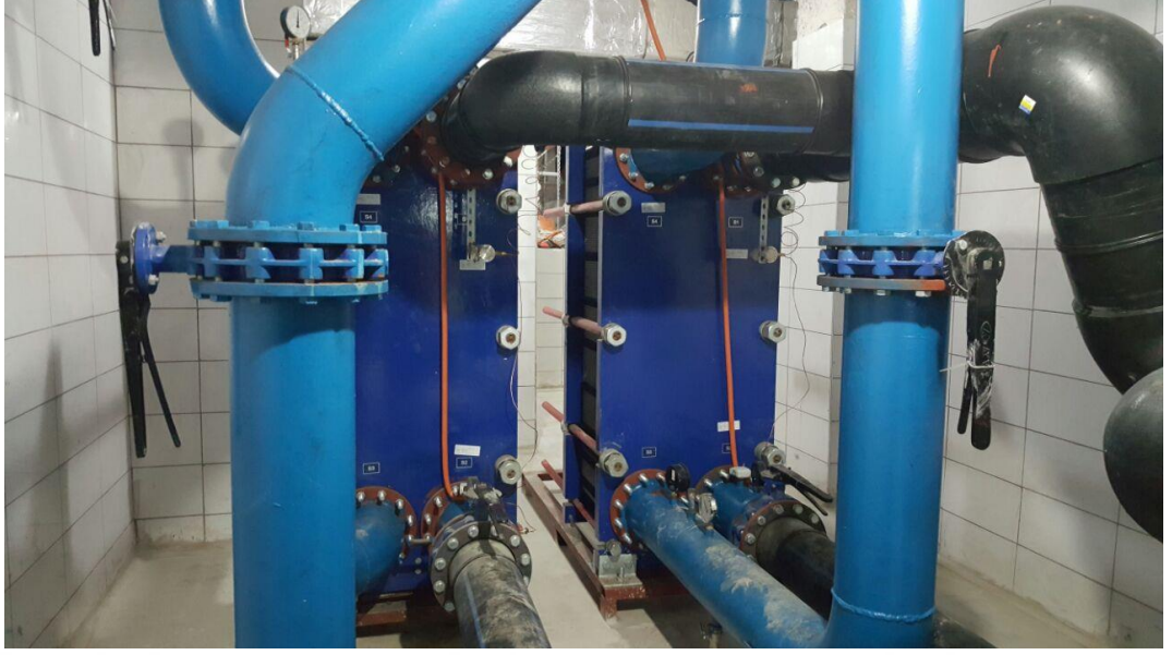
Şekil 4.13. Sistemde kullanılan plakalı tip deniz suyu ısı eşanjörü ve bağlantısı
